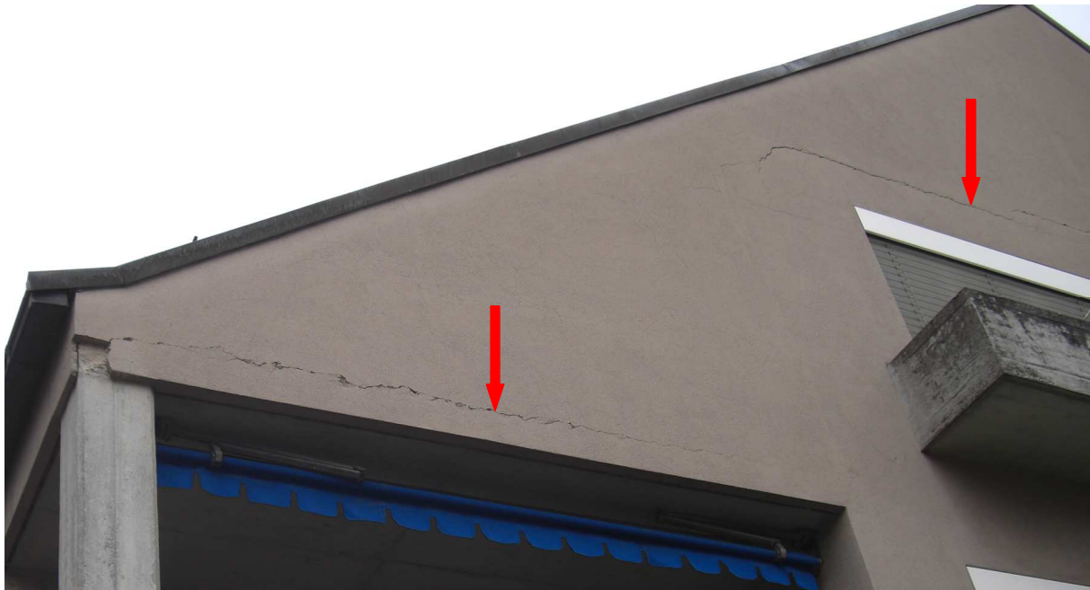
Abb. 11: Generelle Fassadenrisse
