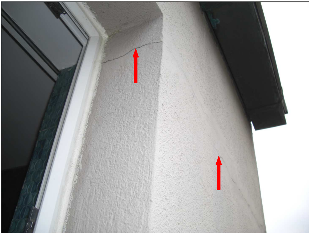
Abb. 5: Aussenansicht Wandriss Eckwand WC
